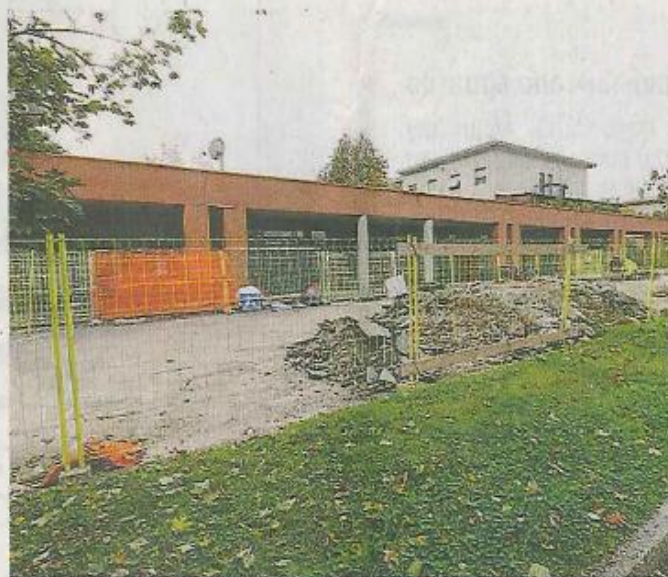
Il cantiere rimasto per mesi e tolto solo da qualche giorno FOTO GIACCAZZI
